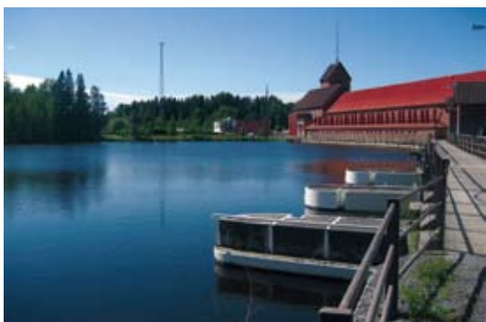
Kuva 8. Kokemäenjoki alkaa Tyrvään voimalaitokselta (ylh.), joka on rakennettu 1950-luvun alussa (Raunio 1992). Äetsän voimalaitos (alh.) on alun perin rakennettu vuonna 1921. (Kuvat: Jonna Konsala 2.7.2008)
