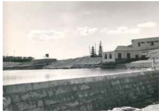
Kuva 2. Halisten vesilaitoksen pato. Kuva: Turun Vesilaitos.
