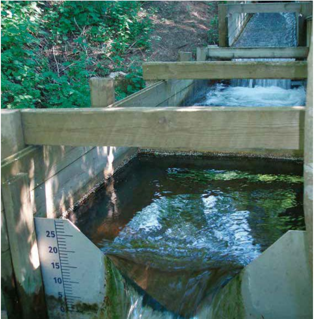
Kuva 18. Alastaron Myllylähteelle asennettu Thompsonin mittapato.
