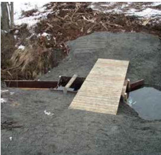
Kuva 31. Kankaanrannan lähteen mittapato.
